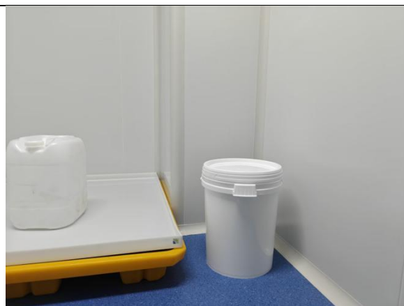
危废贮存间托盘（配套设置应急桶）
